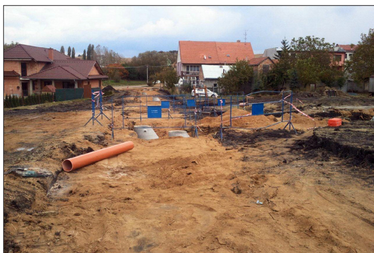
Výstavba inženýrských sítí na budoucí ulici Tocháčkova.
