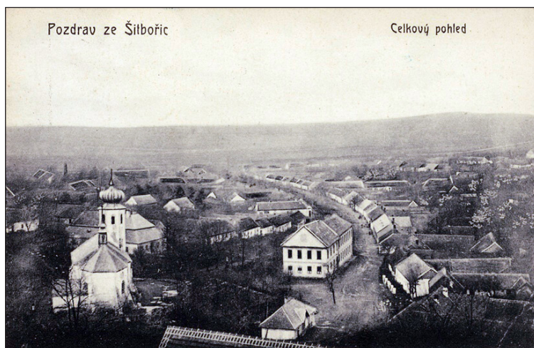
Budova (uprostřed dole) na místě dnešní hasičské zbrojnice, která sloužila jako dřevník a skladiště pro školu kde byl již před rokem 1900 uložen hasičský materiál.
