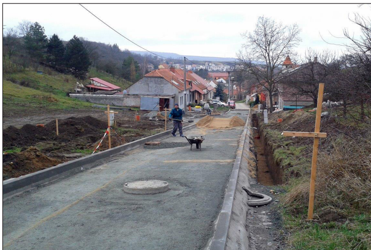
Práce na prodloužení ulice Karpaty I.
