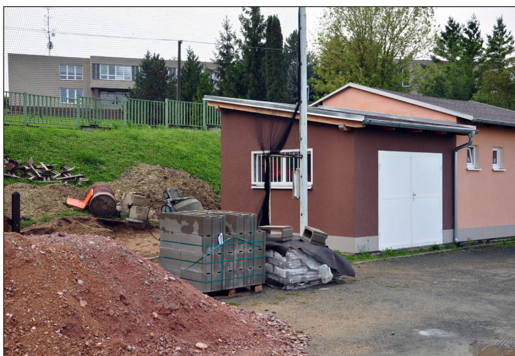
Nový sklad u fotbalového hřiště.
