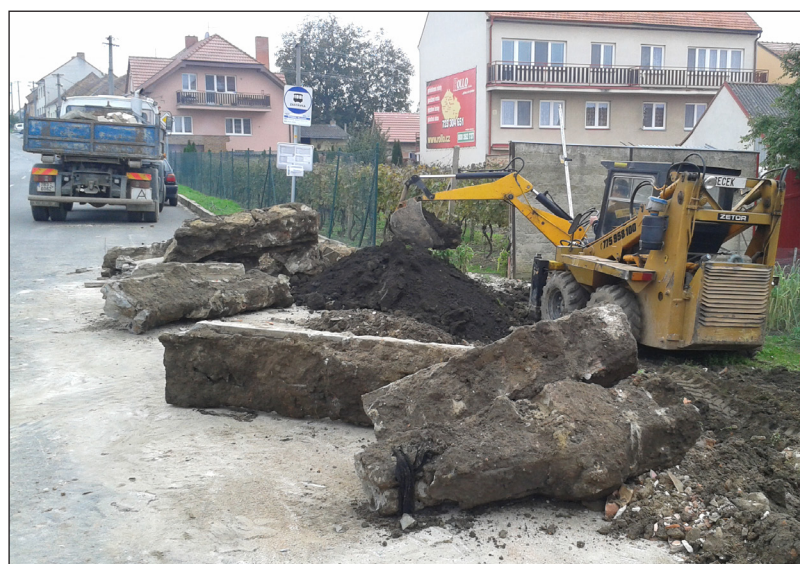
8. 10. 2014 – Bourání staré autobusové zastávky na Nikolčické ulici. foto: Antonín Lngál
