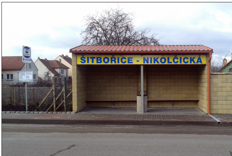
Nová autobusová čekárna na ulici Nikolčická.
