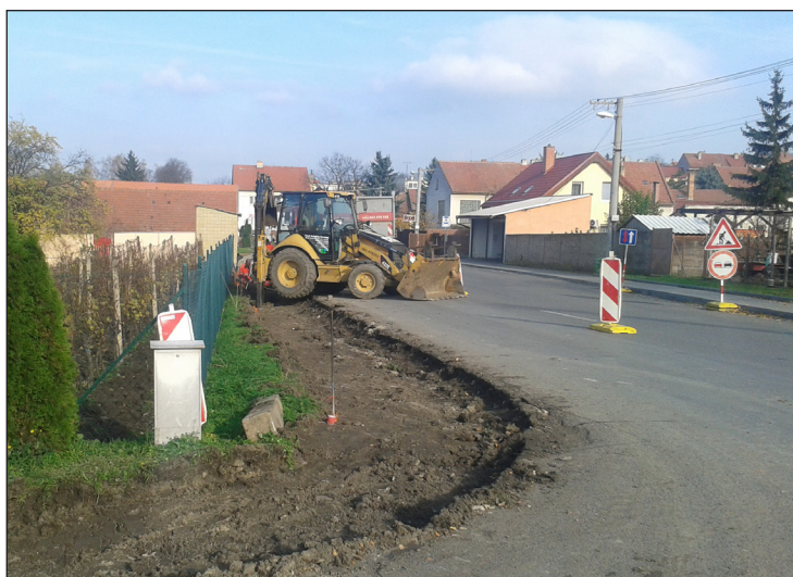
11. 11. 2014 – Budoucí chodník z Mlýnské k zastávce. foto: Antonín Lngál
