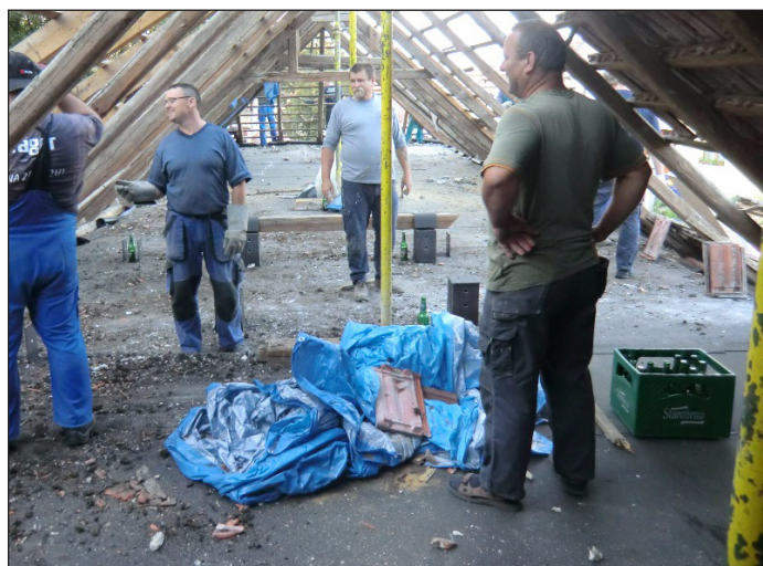
19. 8. 2016 – Sundávání staré střechy hasičárny.
