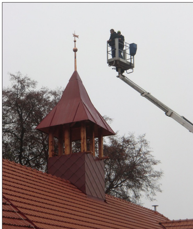
16. 11. 2016 – Instalace nové věže hasičárny.
