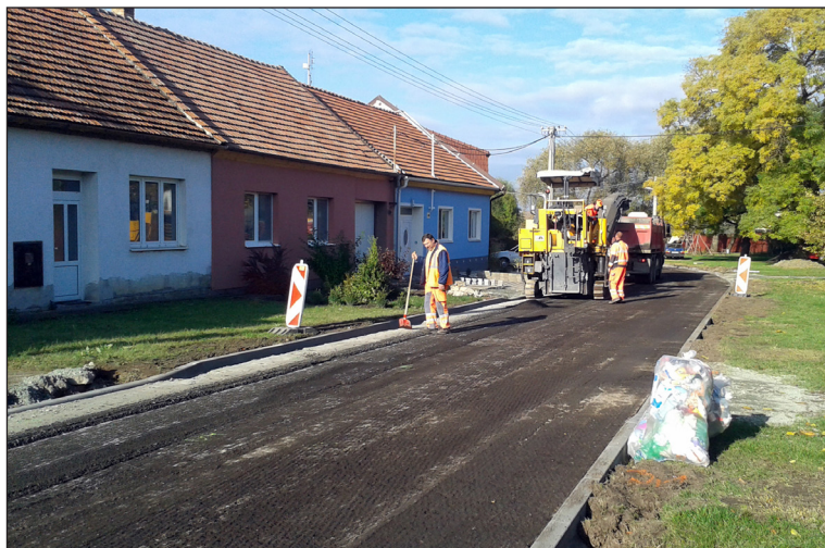
Oprava ulice U Rybníčka.
