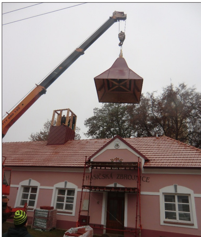
16. 11. 2016 – Instalace nové věže hasičárny.
