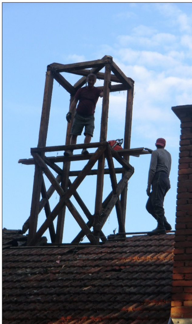
19. 8. 2016 – Demontáž staré věže hasičárny.
