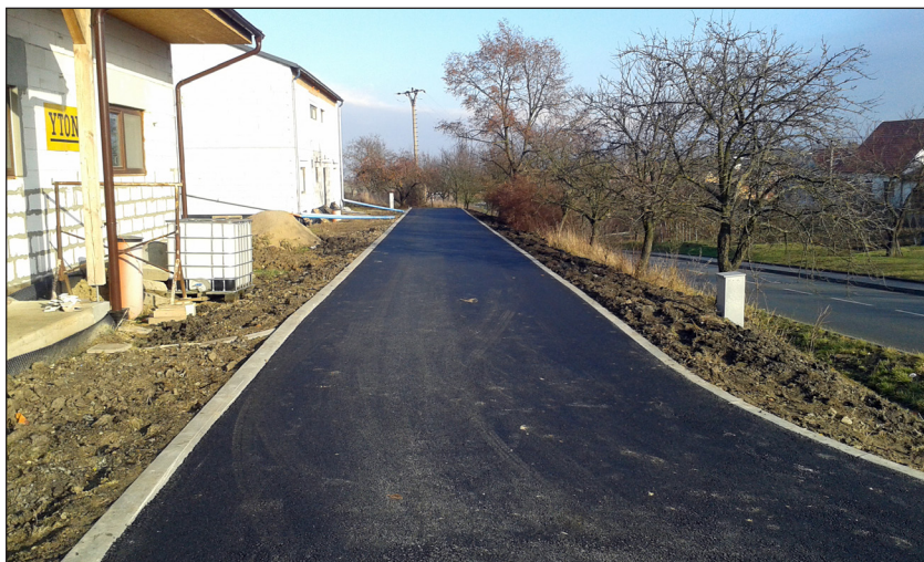
Nová vozovka na ulici Divácká.
