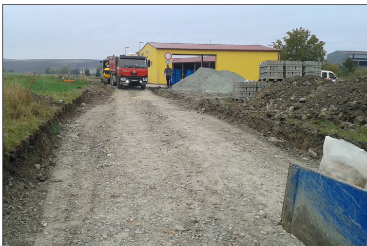
Oprava Mlýnské ulice u sběrného dvora.
