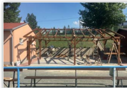
průběh výstavby pergoly – foto: Pavel Relich
