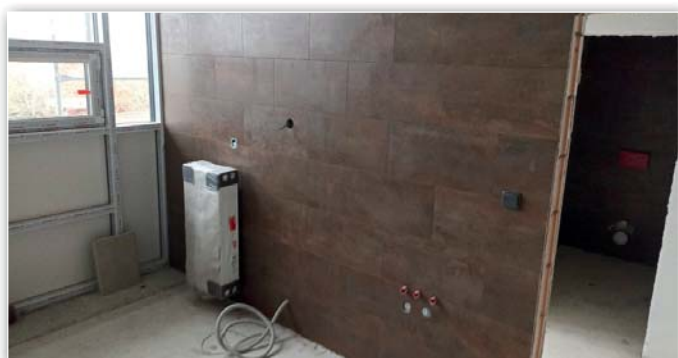
Stavební práce v přístavbě ZŠ
