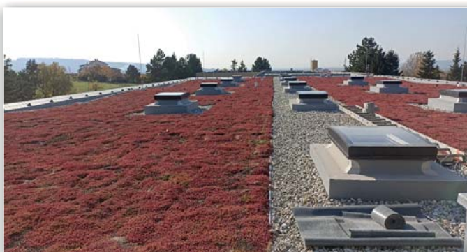
Rozchodníky na střeše přístavby ZŠ vybarvené do krásné podzimní červené barvy
