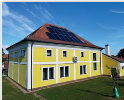
Fotovoltaické panely instalované na střeše obecního úřadu
