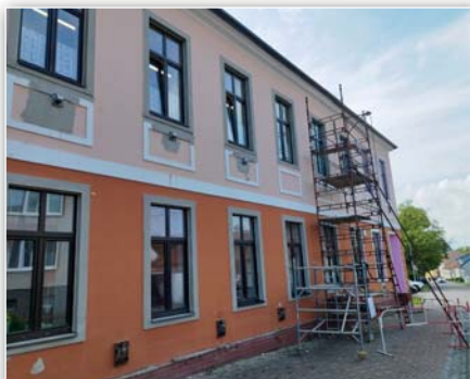
Oprava špalet a fasády na staré škole
