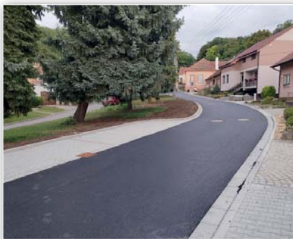
Dokončená komunikace v ul. Na Kopečku
